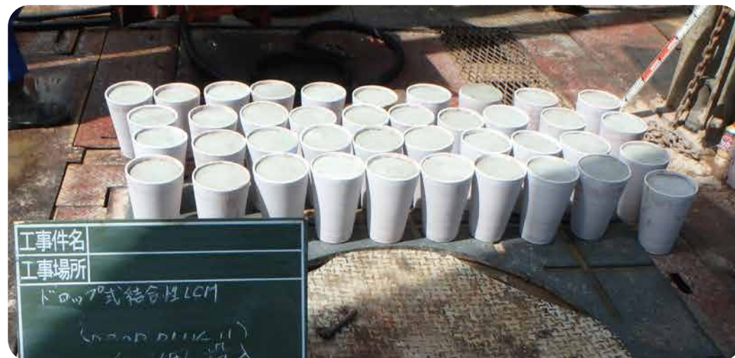
坑内投入直前のドロッププラグ
